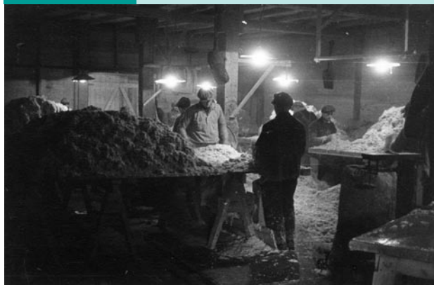
TRAVAILLEURS DE L'AMIANTE – NETTOYAGE DES FIBRES (KING SHED, OCTOBRE 1935)
